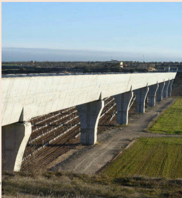
El Canal Segarra-Garrigues a su paso por Tàrrrega (Urgell).
